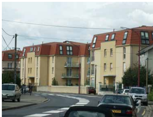
Implantations récentes de collectifs de taille moyenne le long de la rue de la Folie, à l'est de la zone du Sansonnet
