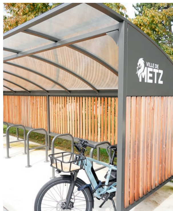
École les Pépinières: construction d'un abri à vélos et trottinettes dans le groupe scolaire rue des Pensées.
